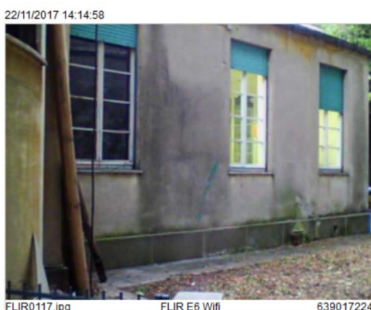
Figura 4.5 – Rilievo termografico dei serramenti
