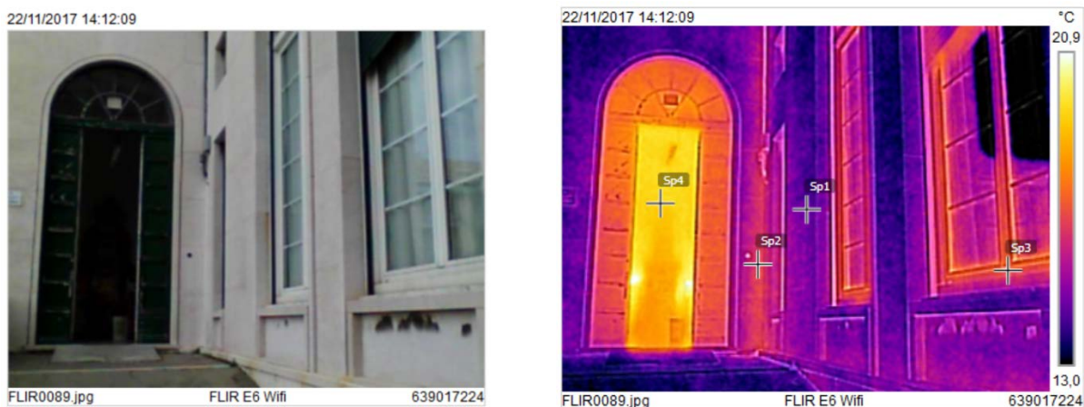
Figura 4.3 – Rilievo termografico della parate Nord-Est e Sud-Est.
