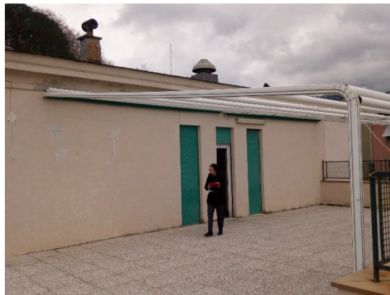
Figura 8.3 - Particolare parete esterna
